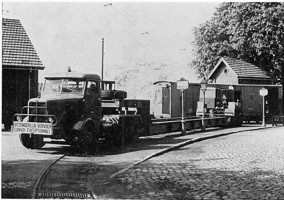
L'entrée du musée au mois de mai 78. Dans le fond, les sous-stations, démolies à présent (Photo W. Hoste).
